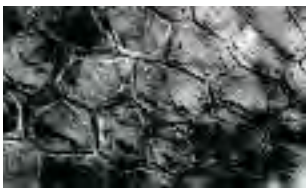
Mosaïque à 6 pans de l'enrochement
