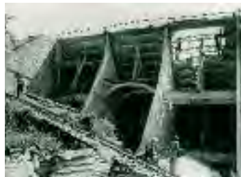
Vue aval du raccordement voûte/culée en enrochement et coffrage des voûtes rive droite (20/07/1950)
