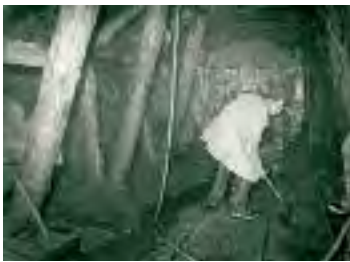
Galerie de fuite, tête aval. enlèvement des déblais (16/11/1948)
