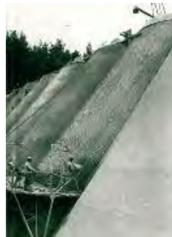
Gunitage de la dernière voûte (25/09/50)
