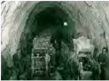
Canal de fuite, vue amont (24/10/1949)
