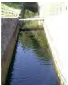
Déversoir vers canal de fuite
