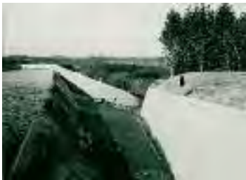
Chambre de mise en charge - Déversoir (11/03/1950)
