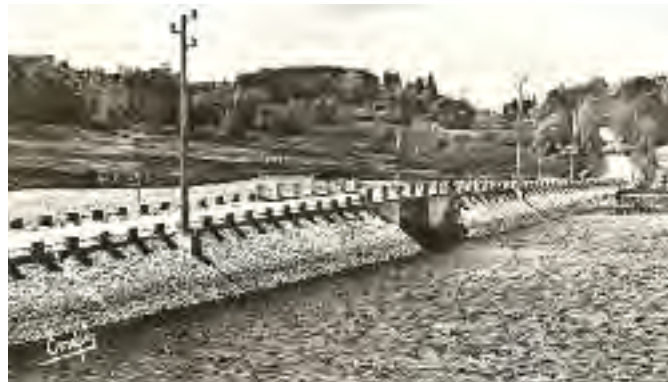
Le pont à la fin du chantier
